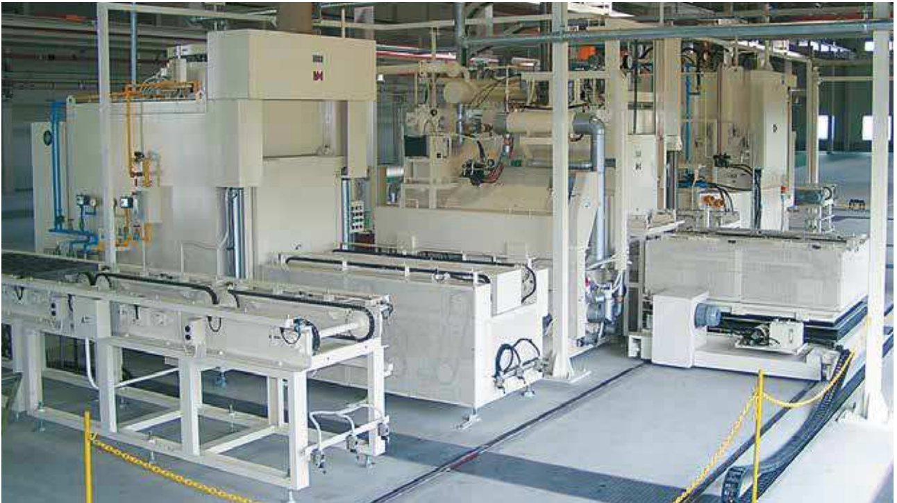
真空浸炭熱処理ライン
