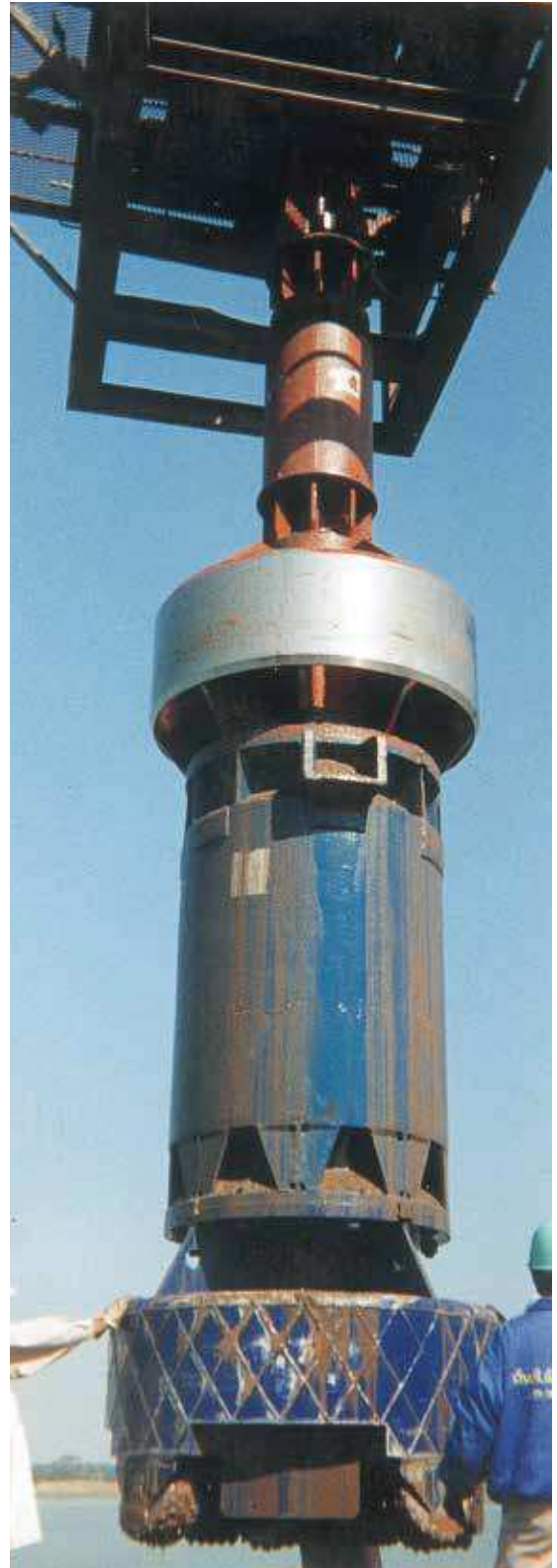
現場使用状況（メコン川橋脚工事）
